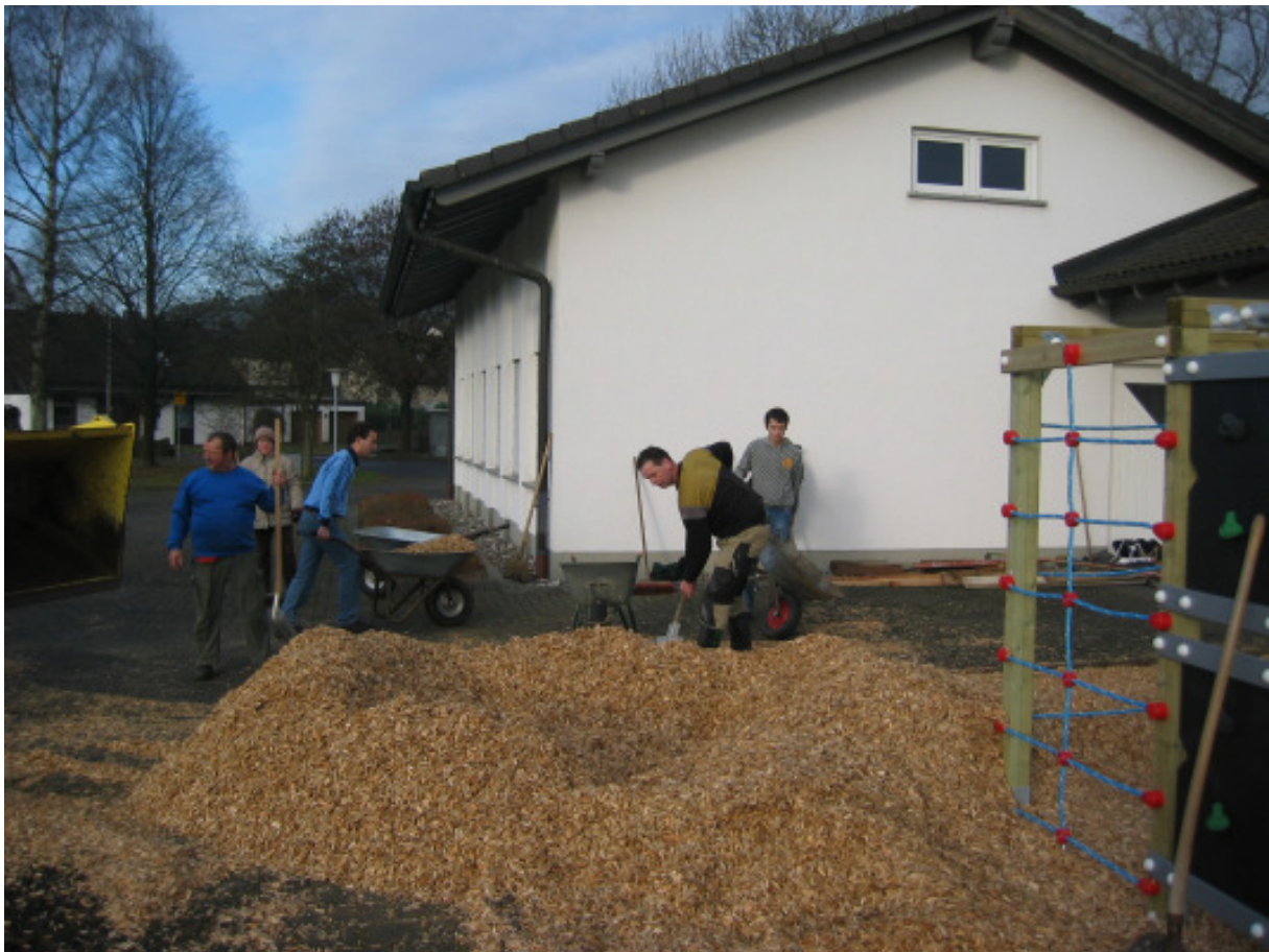
Einbau des Fallschutzmaterials
