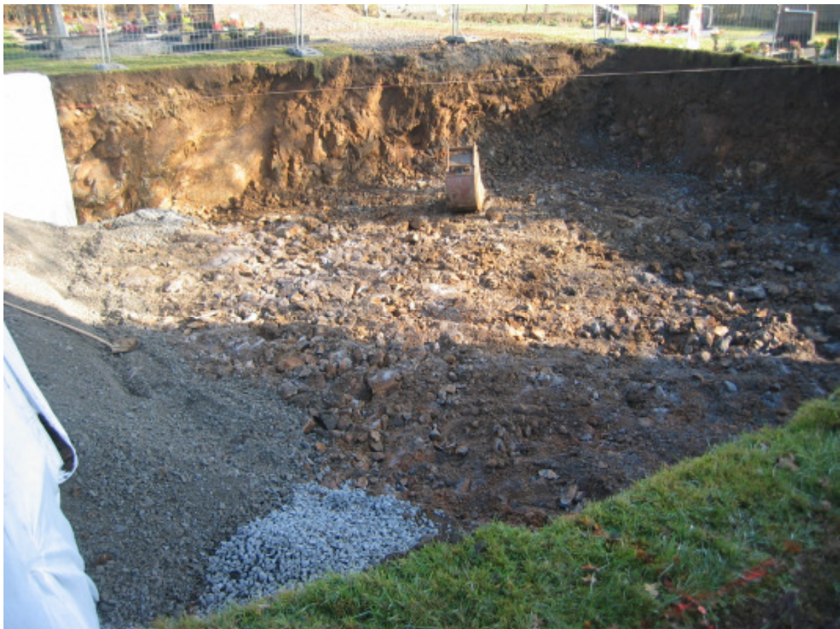
Während der Baumaßnahme
